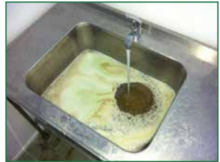
Anlegg med oppløste kalkavleiringer.
