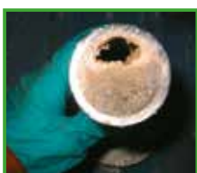
Vakuumsrør med urinsalter
