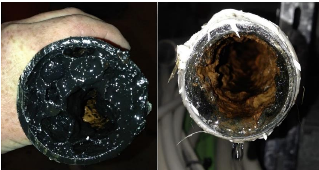
Figur 1 biofilm i rør før og etter behandling med Neuthox (Hagbard Clausen, personlig kommunikasjon, 3. januar 2020)
